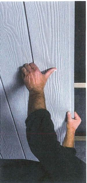
Auf der Holzunterkonstruktion wird das Faserzementpaneel CEDRAL click mit Klammer und Schraube befestigt. Die Grundstoffe der Fassadenpaneele sind Portlandzement, Wasser, Quarzsand und pflanzliche Zellulose.
